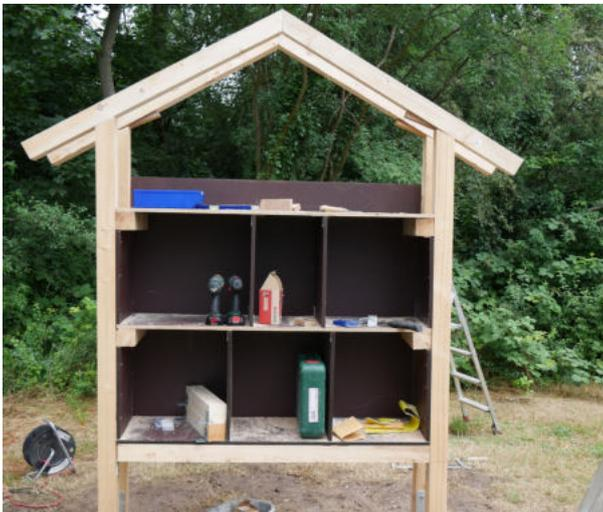
Die Dachabdeckung wird auf die Dachschräge aus den Vierkanthölzern geschraubt und mit kleinen Leisten für die Dachbegrünung versehen.
