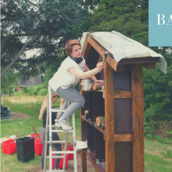
Für die Wetterbeständigkeit wird das unbehandelte Holz mit einer Lasur beschichtet.
