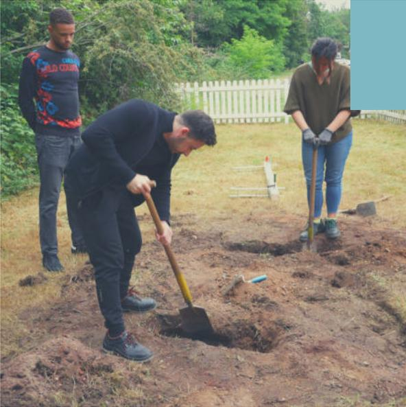
An der ausgewählten Stelle auf der Niederrheinstraße 25 werden zunächst 2 Löcher für das Fundament ausgekoffert und anschließend mit Betonestrich verfüllt.
