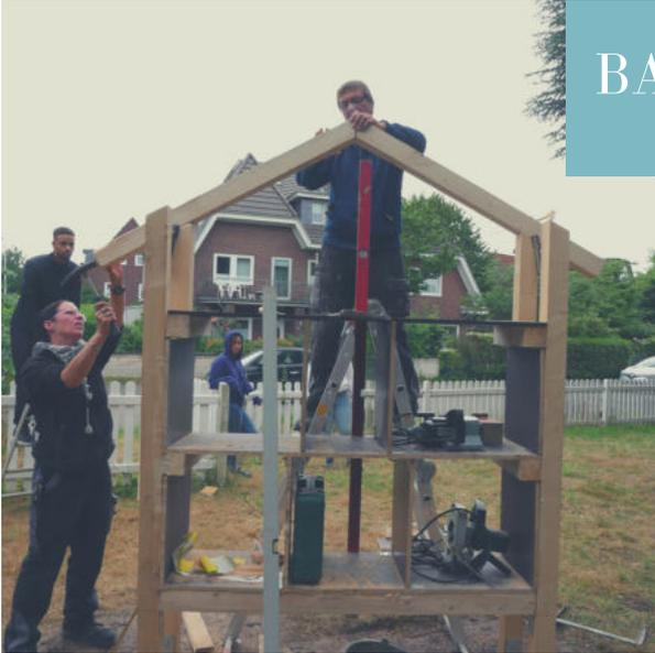
Für das Dach werden ebenfalls Vierkanthölzer zugeschnitten und ausgerichtet.
